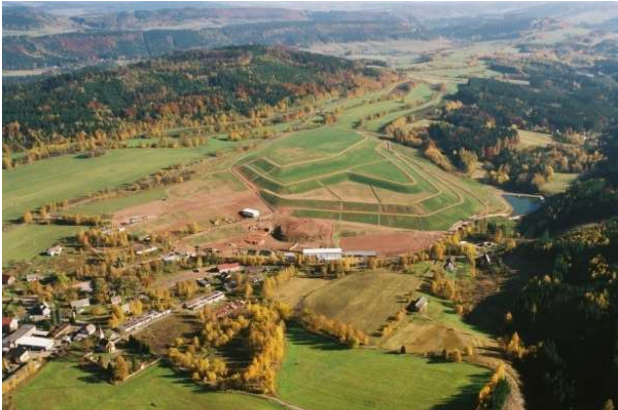
Obrázek č. 1 : Stav technické sanace odvalu Kateřina v roce 2006
