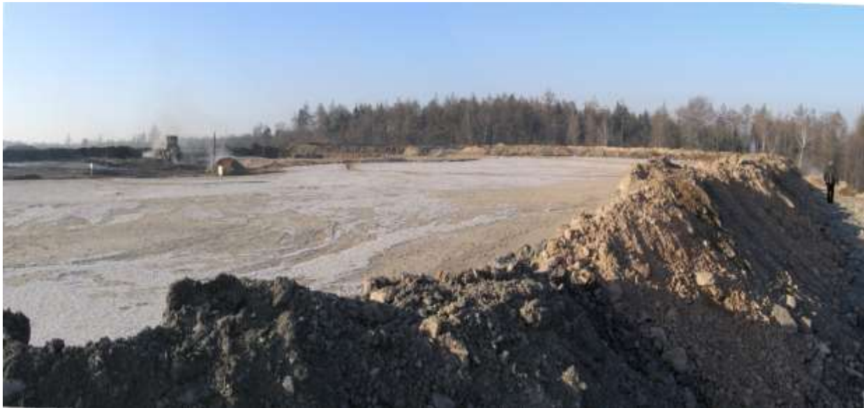
Obrázek č. 2 : Zatěsnění temene odvalu Schoeller
