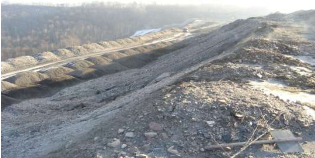
Obrázek č. 3: Provádění těsnění odvalu
