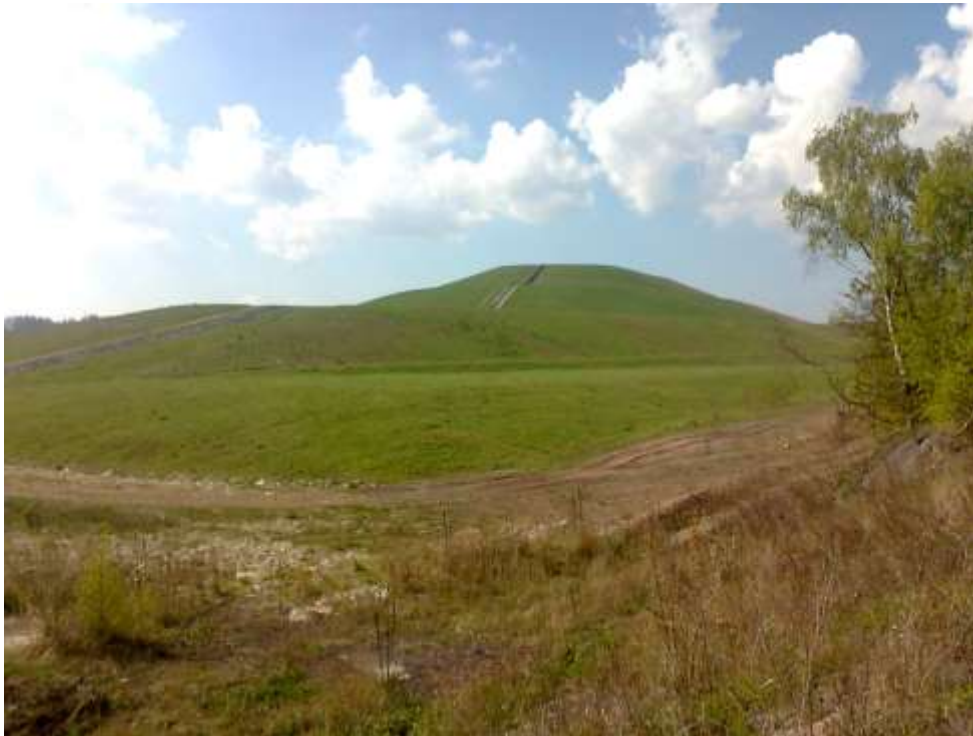
Obrázek č. 5.: Odval bývalého dolu Tuchlovice 2014
