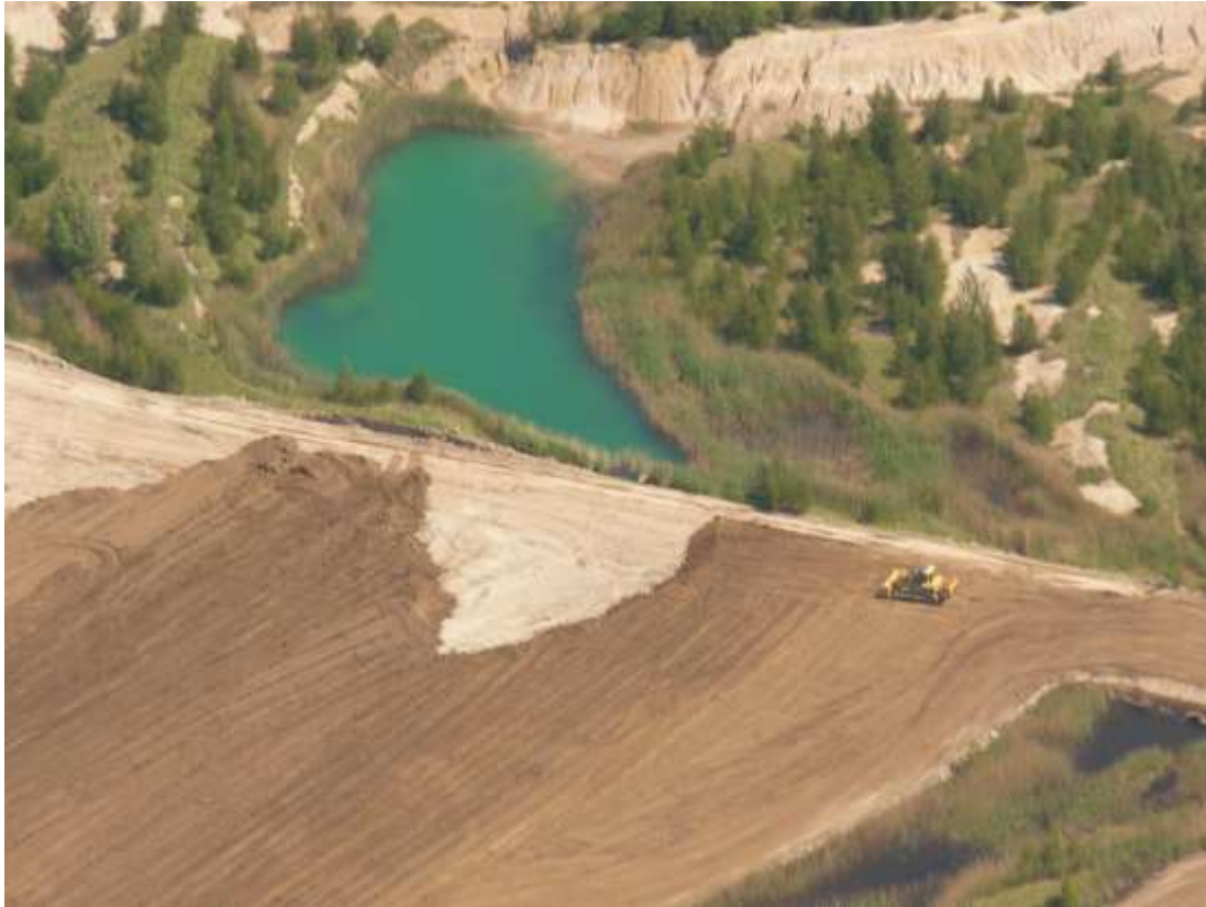
Obrázek č. 1: Hranice plochy Radovesice XVII A ponechané přirozené sukcesi a okolní technické rekultivace
