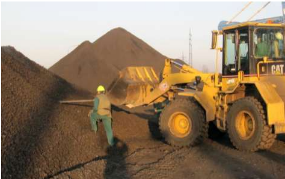
Obrázek 1 – Instalace měřicí sondy
