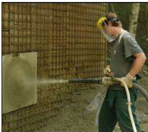
Obr. 3 – Ukázka z nástřiku bentonitu technologií Stříkaného backfillu a grafické znázornění výsledků zhutnění bentonitu po nástřiku, z grafu je patrný vliv přítoku vody do nástřikové trysky (water inflow) na dosažené zhutnění - objemovou hmotnost sušiny (dry density v \text{g/cm}^3 ) a vlhkost (water content v %) [1.]
