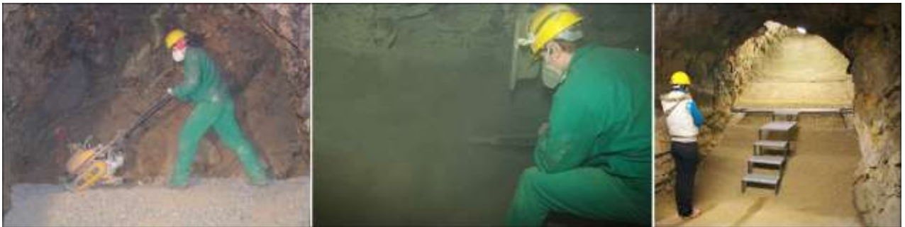
Obr. 2 – Výstavba modelu zaplnění přístupových štol hlubinného úložiště v jedné ze štol Podzemní laboratoře Josef [1.]
