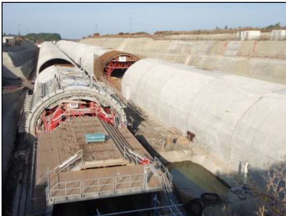
Obr. 3 Realizace rozsáhlé hloubené části tunelu – Lochkovský portál
