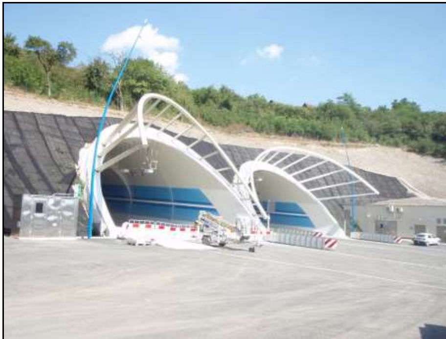
Obr. 7 Tunely těsně před dokončením - Lahovický portál
