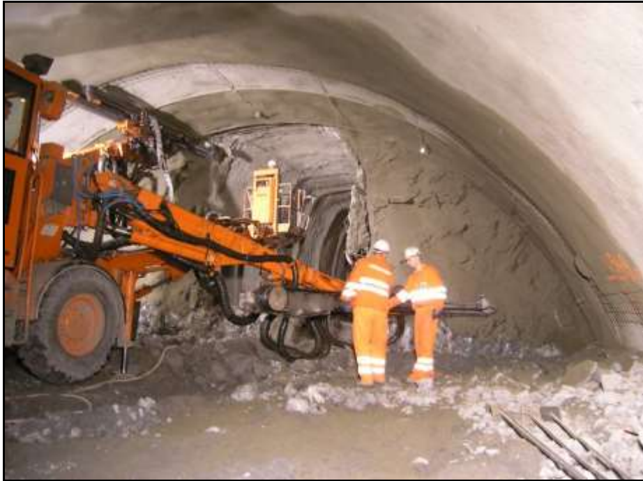
Obr. 2 Ražba tunelové roury 3PT s průzkumnou štolou
