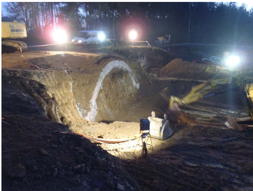
Příloha č. 5 Začátek ražeb – jižní portál
