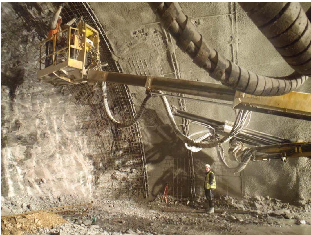
Příloha č. 6 Stavební práce ve zdravých rulách
