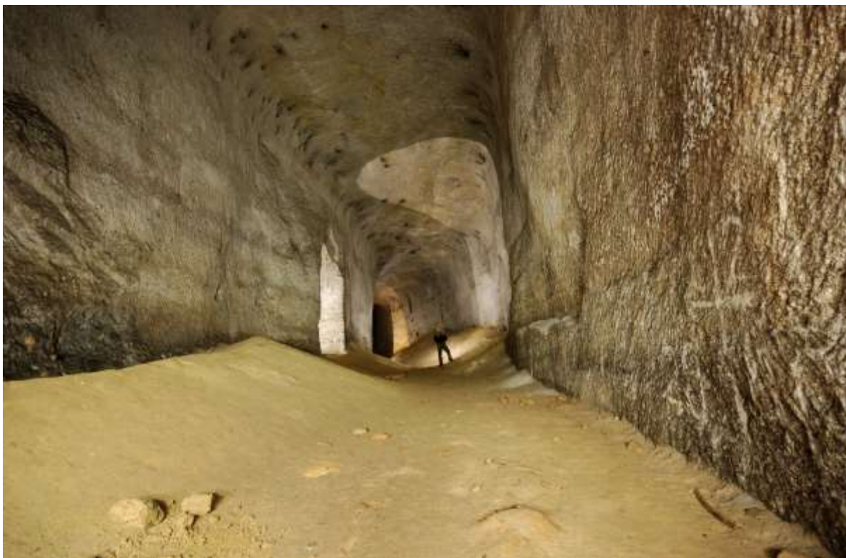
obr. 5 Prostorná, původně až 16 m vysoká kaverna vyrubaná v kaolinovém dole. Foto M. Korba, 2014
