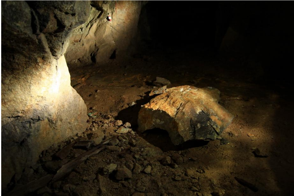
Obr. 2 Uvolněný kus horniny ze stropu
