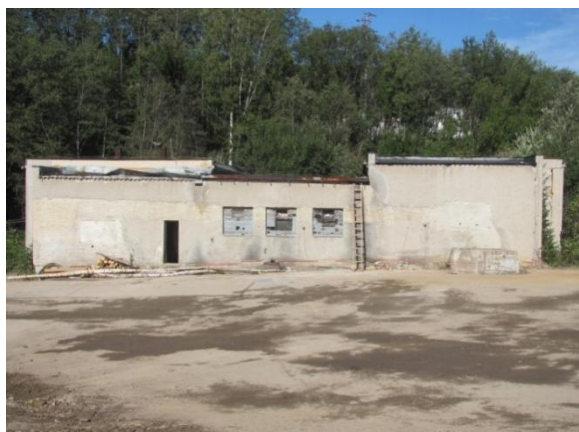
Obr. 2: Budova bývalého ohřevu vtažných větrů
