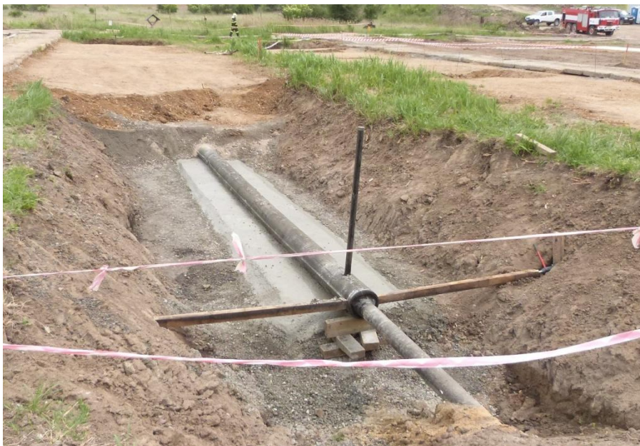
Obr. 2: Princip realizace chrániček na produktovodech
