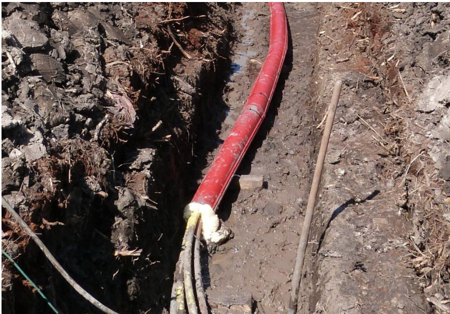
Obr. 4: Instalace dělené chráničky před obetonováním
