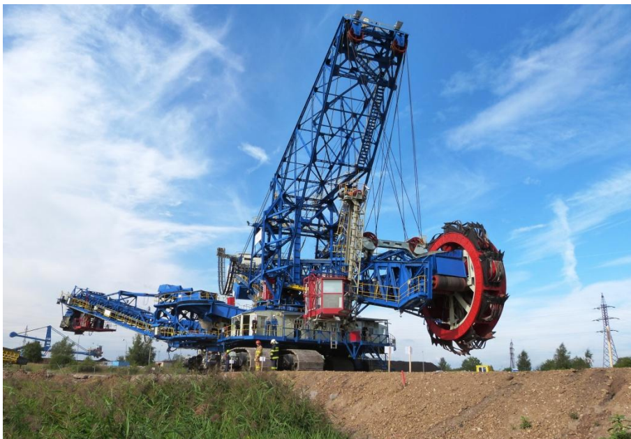
Obr. 6: Transport rypadla přes produktovody Hořanského koridoru
