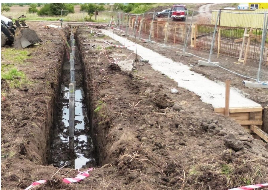
Obr. 3: Realizace přemostění plynovodu za pomoci mikropilot
