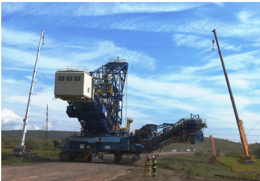
Obr. 7: Transport rypadla pod kombinovaným zemním lanem VVN 110 kV
