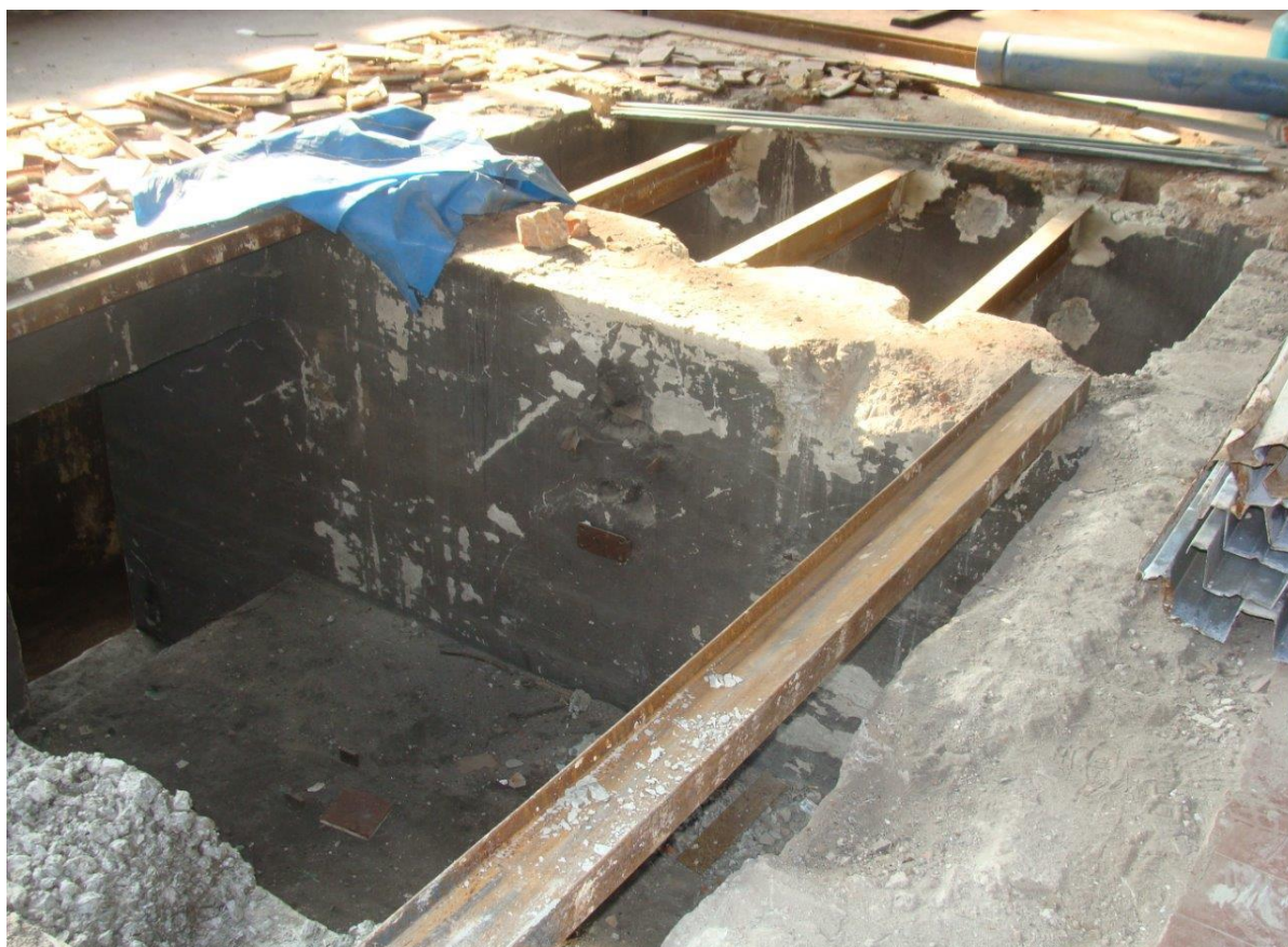
Obr. č. 11 – otvory v podlaze kompresorovny
