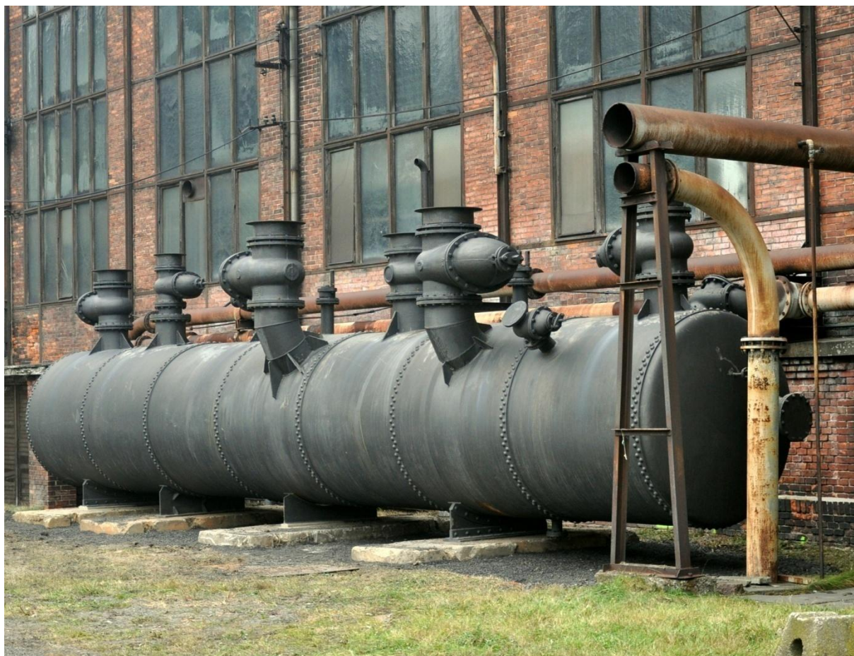
Obr. č. 7 – 1. vyrovnávací tlaková nádoba na Dole Michal
