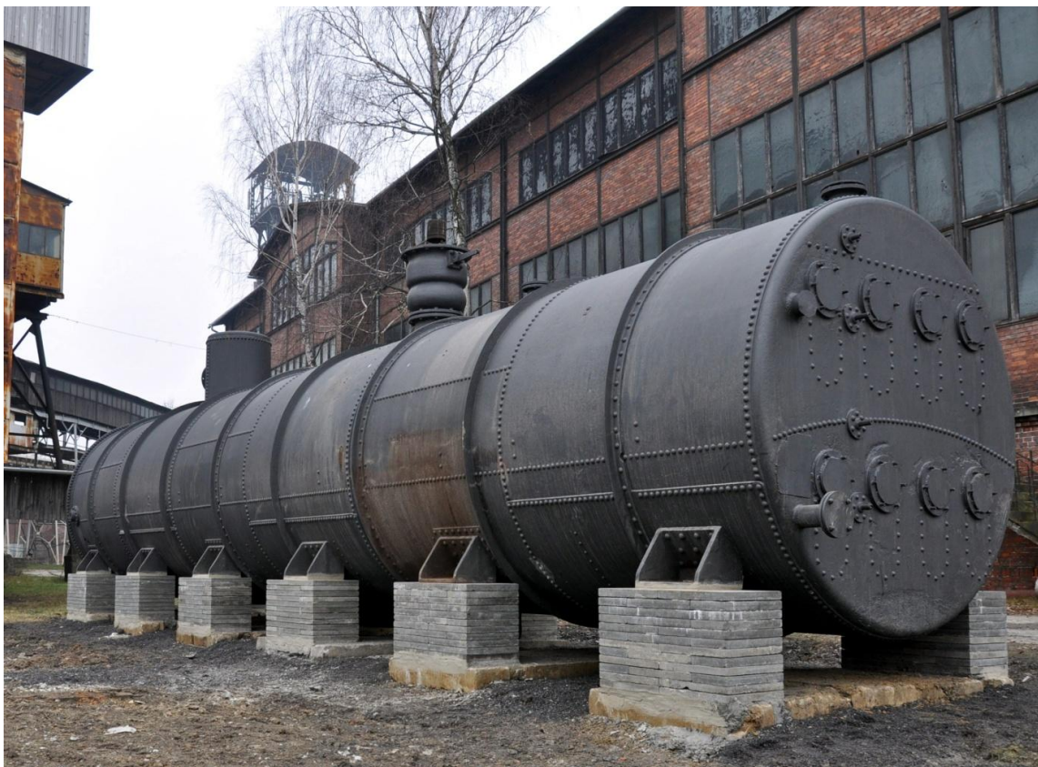
Obr. č. 8 – 2. vyrovnávací tlaková nádoba na Dole Michal
