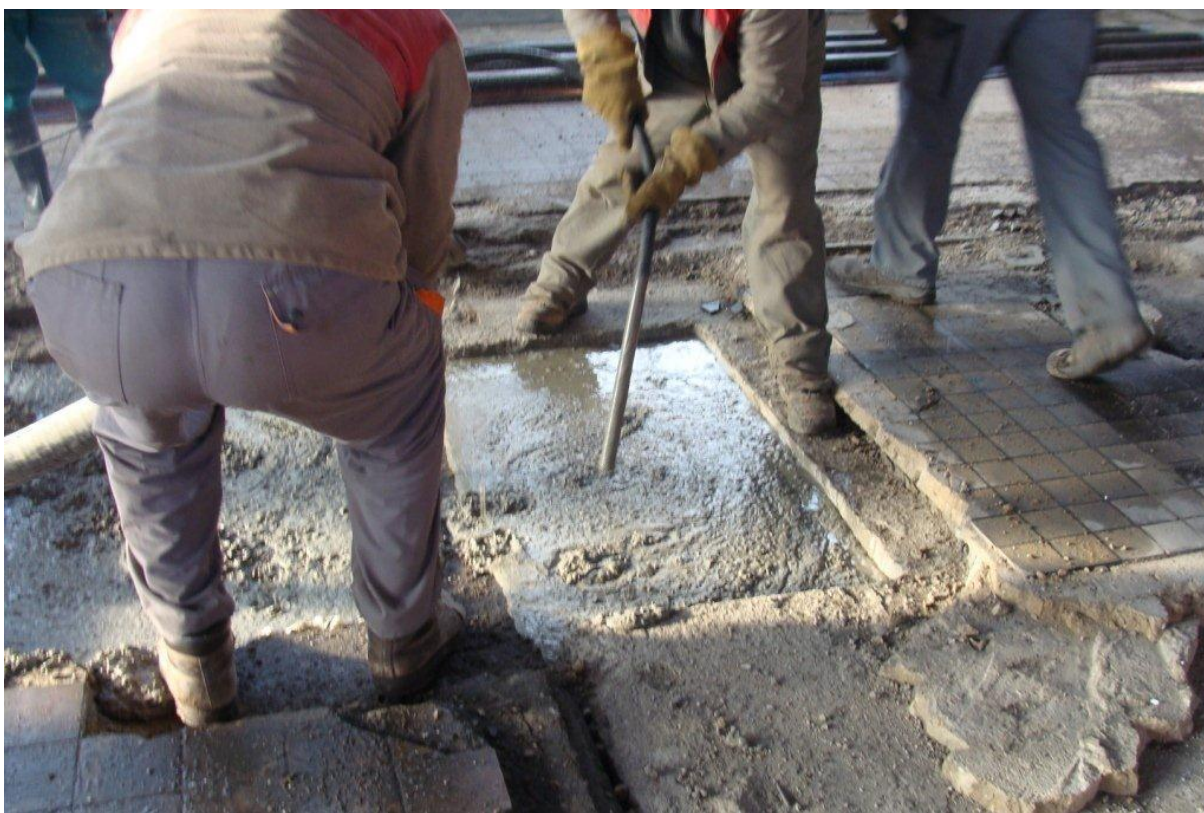
Obr. č. 13 – betonáž otvorů v podlaze kompresorovny
