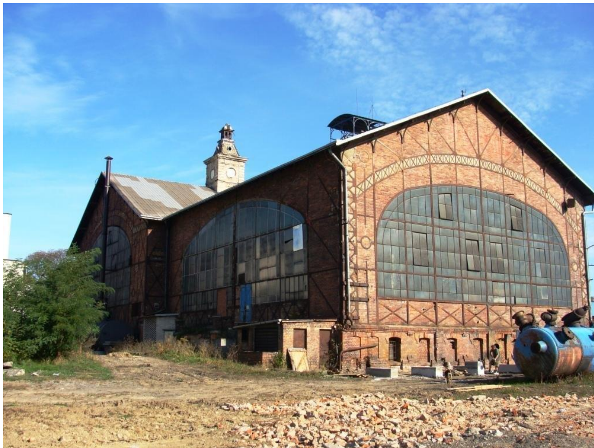
Obr. č.2 – kompresorovna, strojovna
