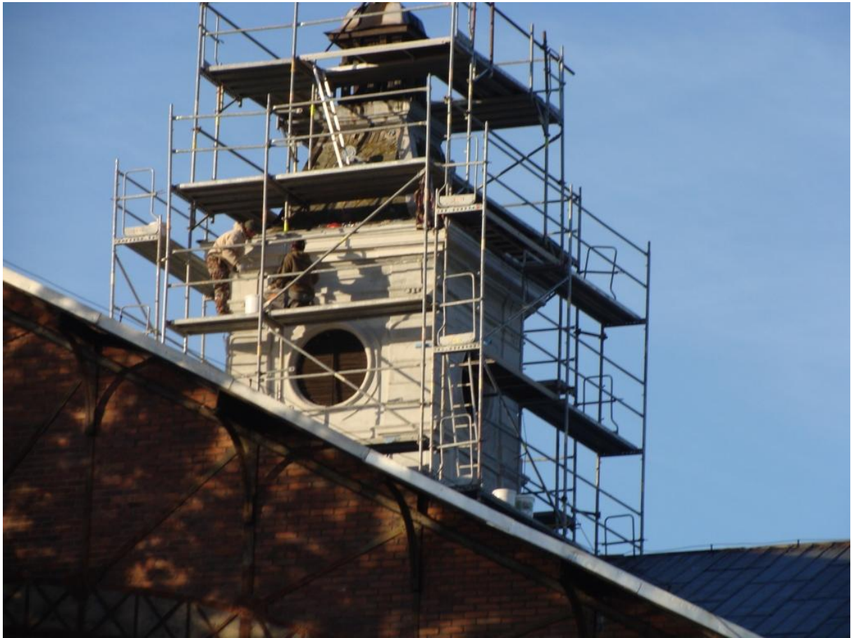
Obr. 3 – oprava věže budovy kompresorovny, strojovny
