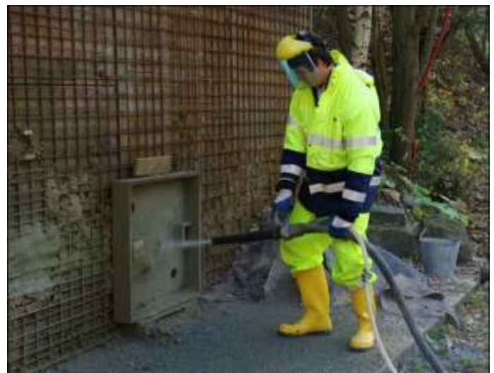
Obr 6. Cvičná stěna pro stříkaný backfill.
