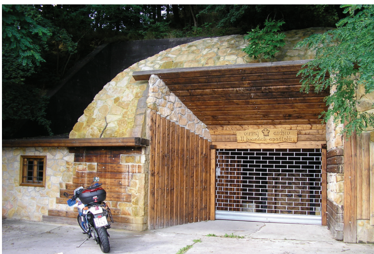
Obr. 2 Upravený portál vinného archivu, v pozadí betonová zeď
