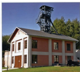
Obr. 7 - Těžní věž dolu Wilhelm – po úpravách počátkem 21. Stol.(Prospekt)
