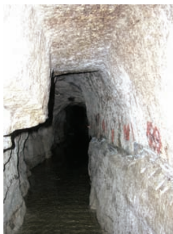
Obr.3a Chodba CH211) (foto Kaláb 2009)
