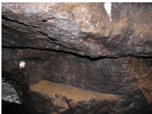
Obr.5 a 5a – Nika s protikusem ve stěnách komory K32, rozměr niky 25 x 25 cm (obě foto Tyller, 2011)
