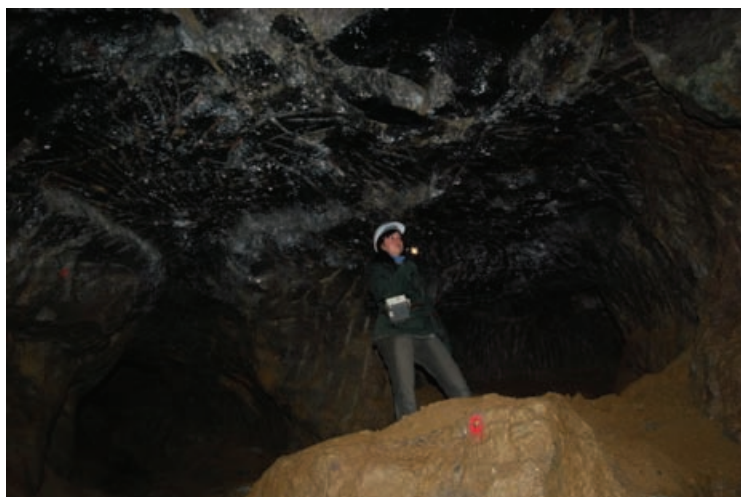
Obr.10 – Začerněné stropy komor.(foto Klier, 2009)
