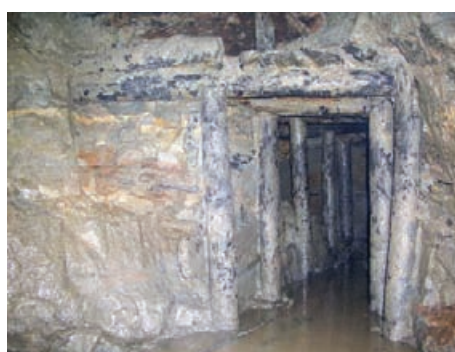
Obr.15 - Dřevěná výdřeva (foto Šefrna, 2004).
