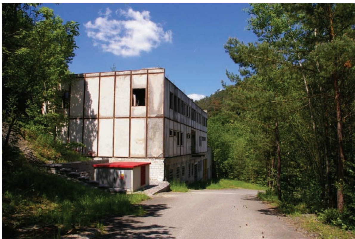
Obr.1 – Šachetní objekt před rekonstrukcí
