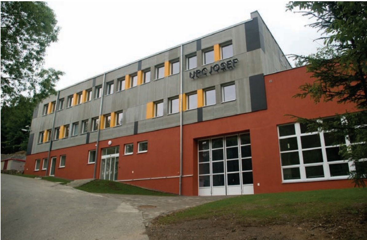
Obr.2 – Zrekonstruovaná budova URC Josef
