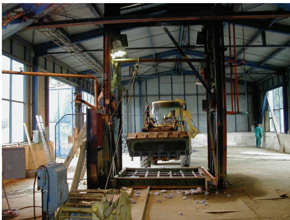
Obr. 3 Zásyp jámového stvolu Pomocné jámy
