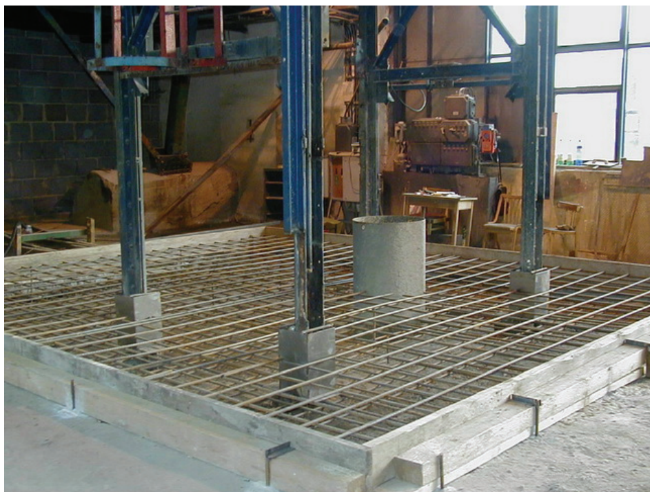
Obr. 4 Výroba uzavíracího ohlubňového povalu
