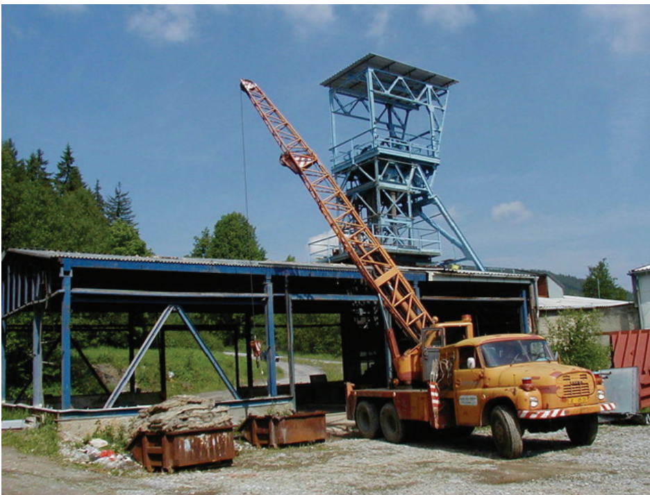
Obr. 1 Demontáž budovy těžního stroje Pomocné jámy
