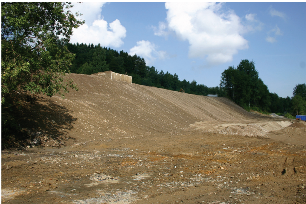
Obr. 12 Sanace v místech bývalé flotační úpravy
