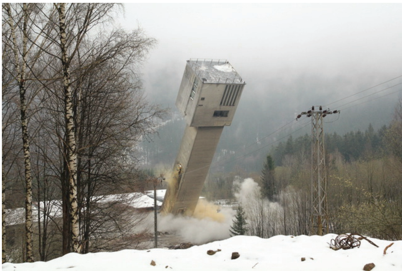
Obr. 9 Odstřel těžní věže
