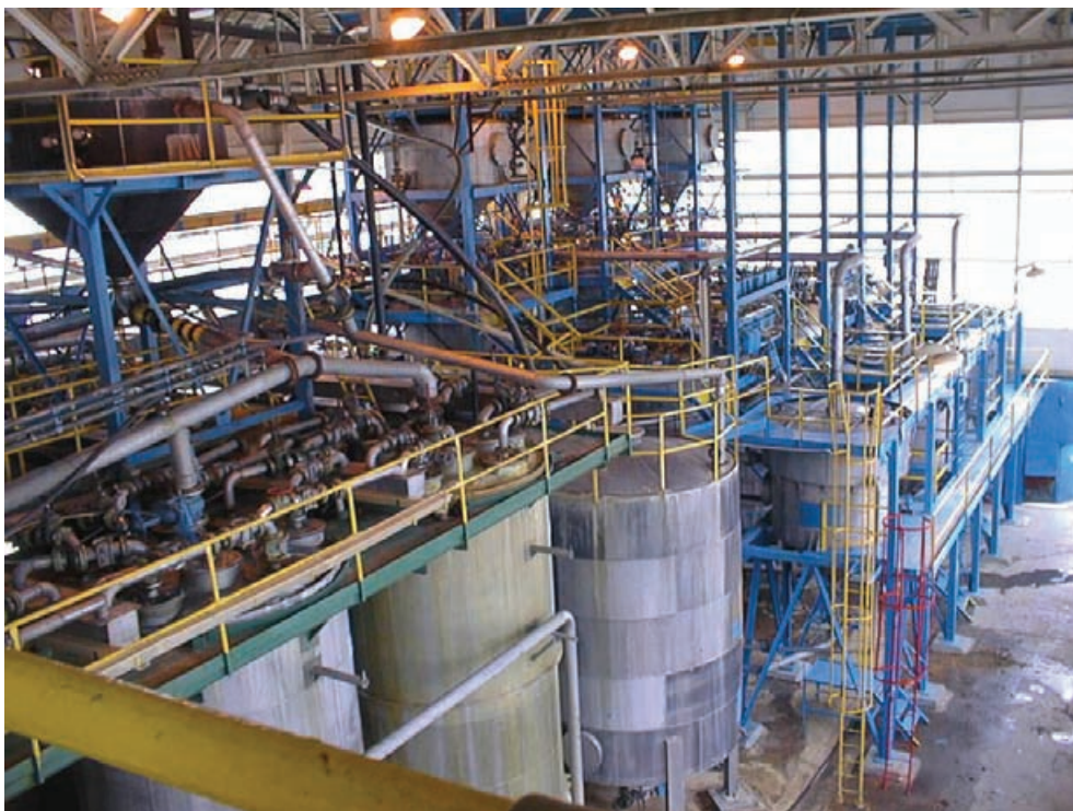
Obr. č. 2 Chemická stanice, separace uranu
