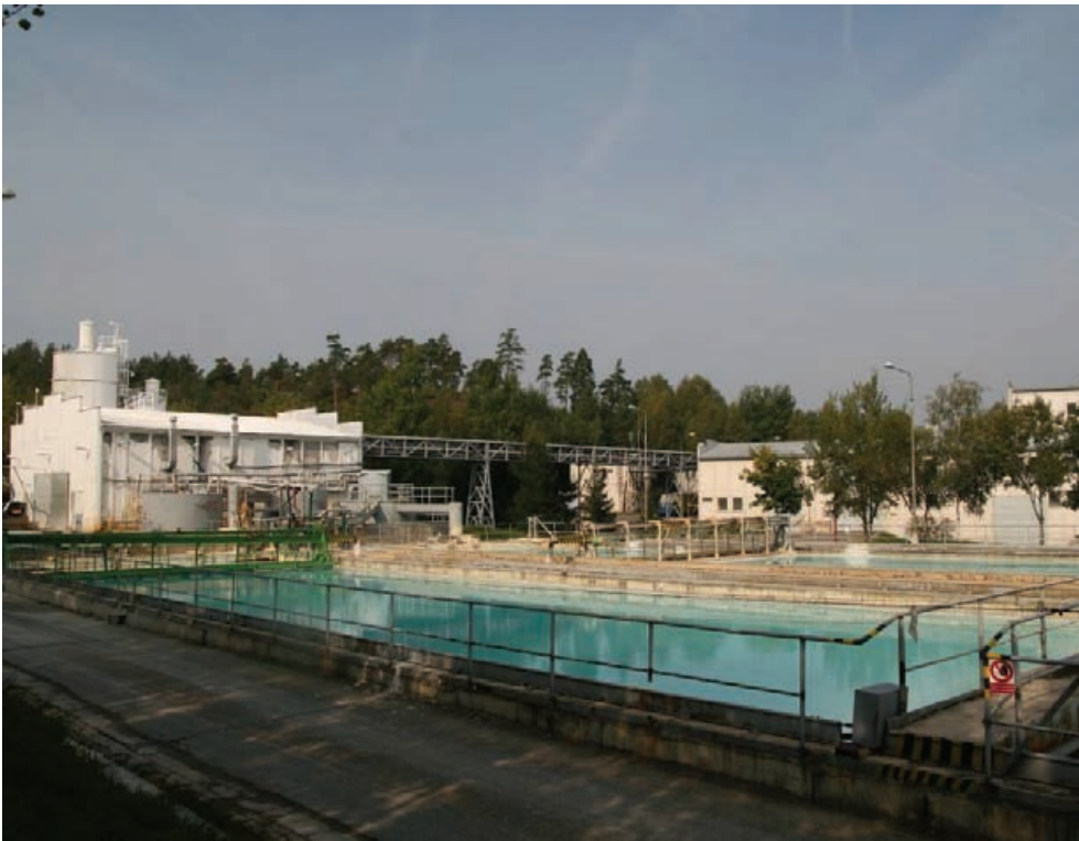
Obr. č. 3 NDS-6, neutralizační stanice
