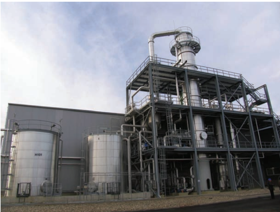
Obr. č. 6 Technologie ZML - stripovací jednotka
