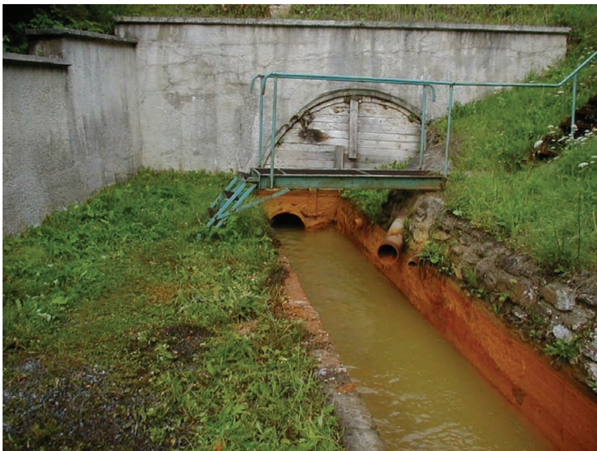
Ústí odvodňovací štoly
