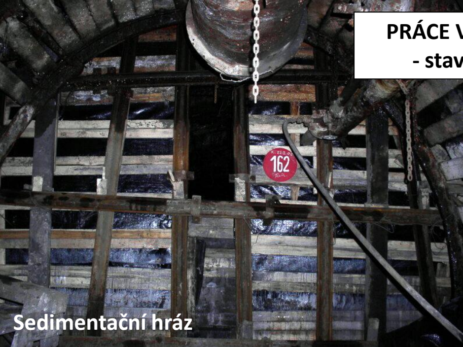
Vnitřní strana sedimentační hráze
