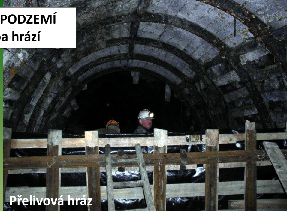
Stavba sedimentační hráze
