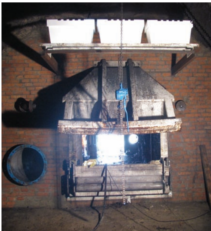
Obr. 6 PDIO-7 s hmotnostní pojistkou – vodní korýtka
