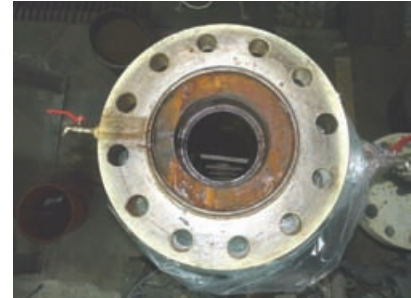
Obr. č. 3 – Pohled na vsázku ve filtrační komoře po sejmutí těsnicího víka (foto autorka).
