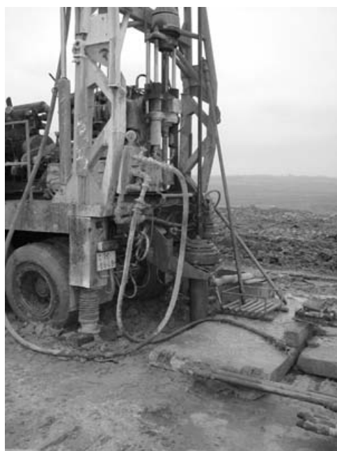
Obr. 1. Vrtné práce soupravou ZIF 650 (foto autor).
