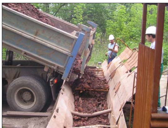
Obr. 3.9 Kontrola kusovitosti zásypového materiálu
