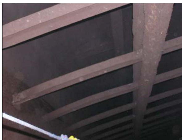
Obr. 3.10 Stav jámového stvolu a výstroje jámy v průběhu sypání
