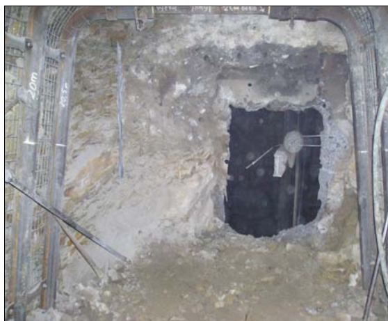
Obr. 3.7 Proražení dopravní štolý do jámy Kukla
