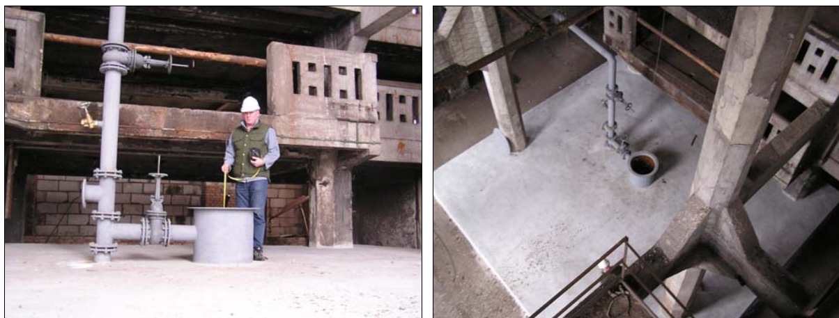
Obr. 3.11 Ohlubňový poval jámy Kukla v Oslavanech
