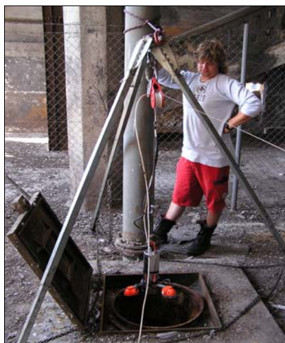
Obr. 3.5 Rekognoskace (video-dokumentace) stvolu jámy před zahájením likvidace 2004
