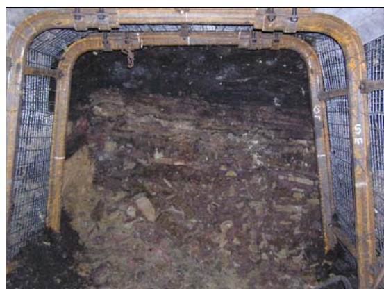
Obr. 3.3 Ražba dopravní štoly
