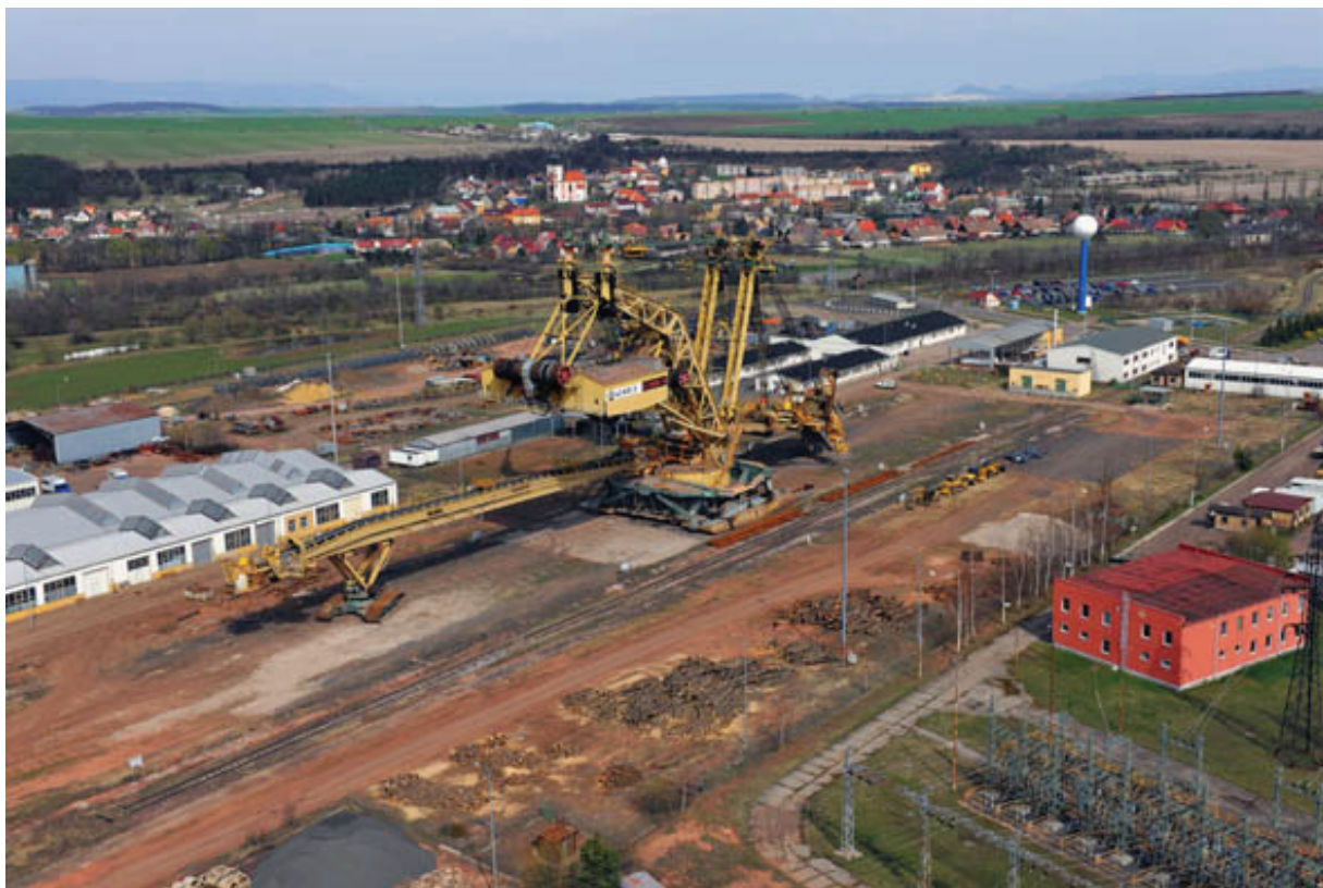
Obr. 6 Montážní místo Březno s odstaveným velkostrojem
