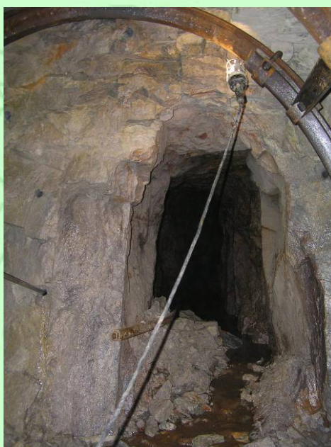
Obr. 2 Fotografie z rekonstrukce dědičné štoly Jeroným (srpen 2005)
