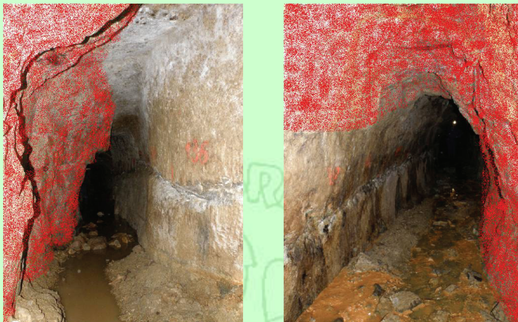
Obr. 5 Fotografie chodeb na štolovém patře (nezabarvené plochy jsou nejstarší dobývky s pozůstatky ručních prací, červeně jsou zabarvena místa vydobytá později ze starého profilu)
