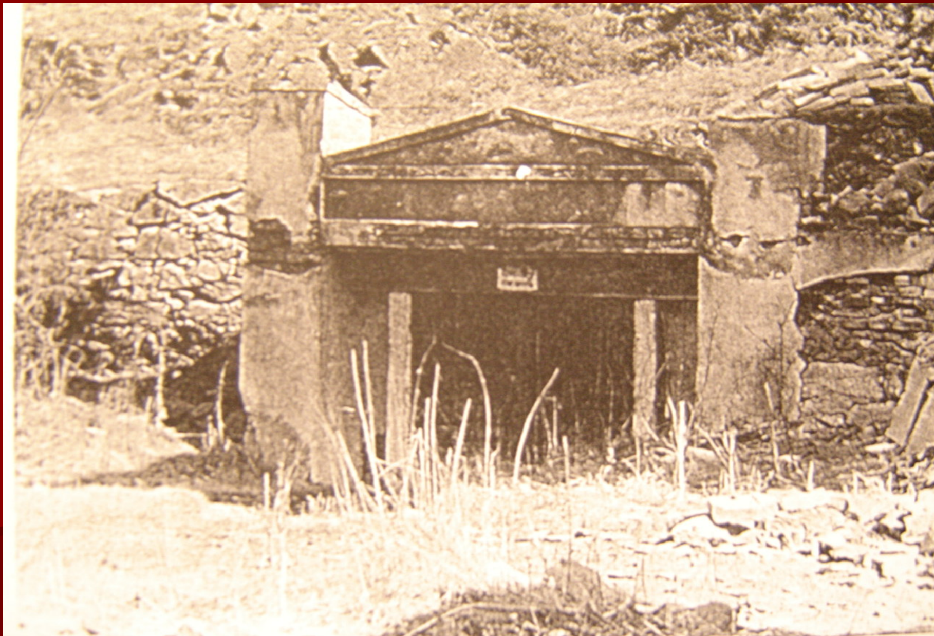
Pohled na portál štoly Prokop
