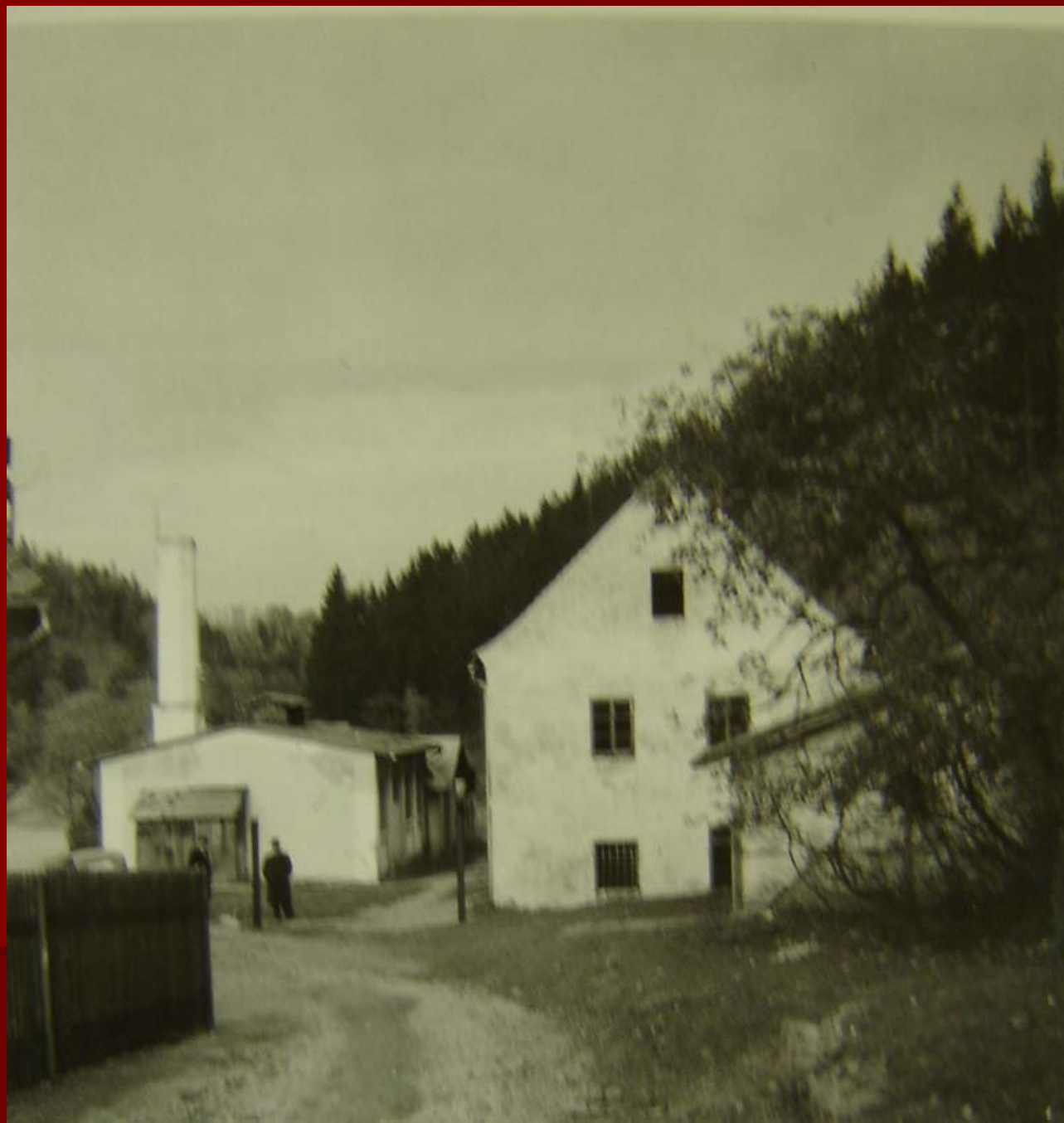
Provozní objekty u ústí dědičné štoly PROKOP
