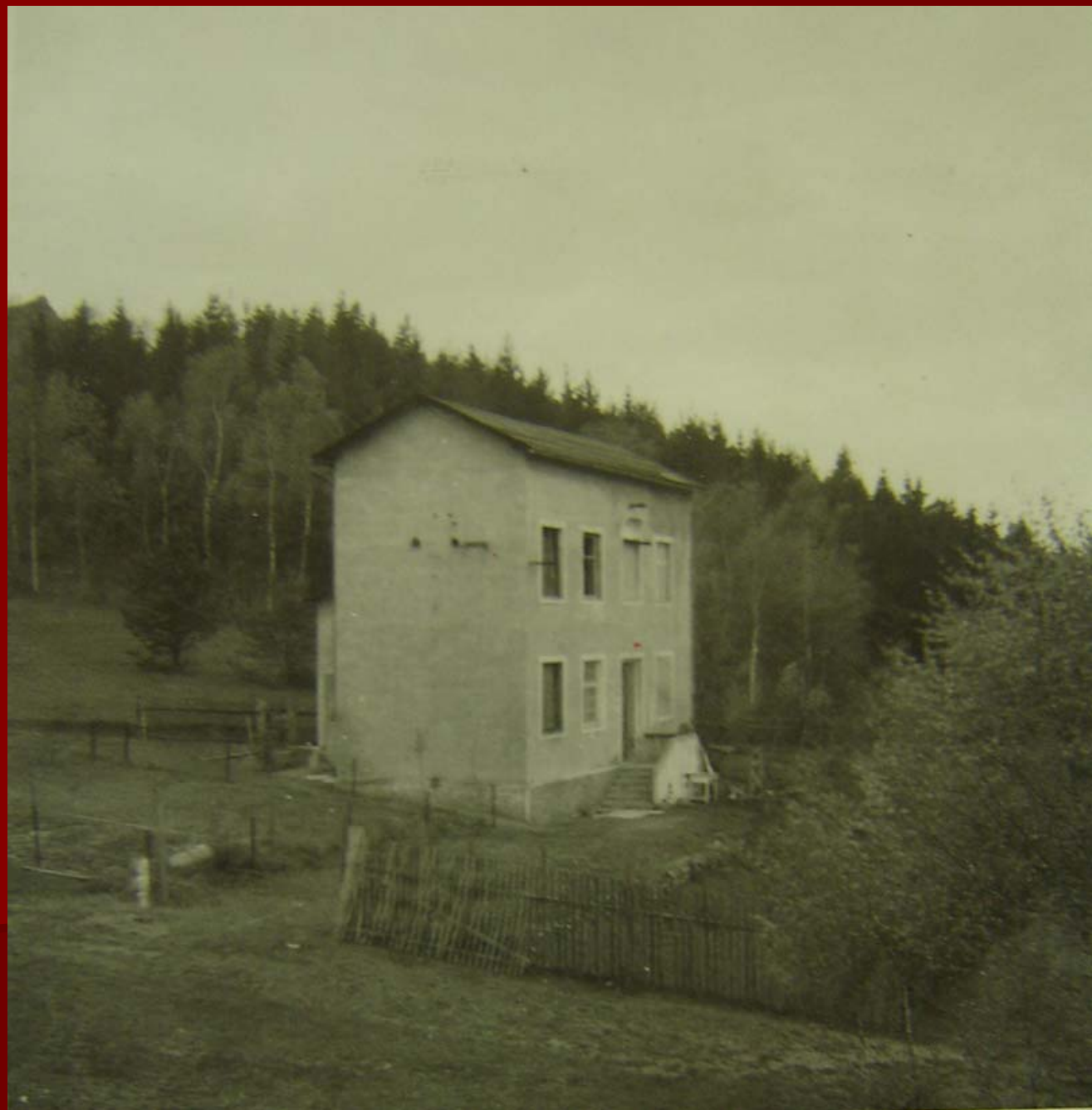
Bývalá transformátorovna dolu LEO ve Svinné
