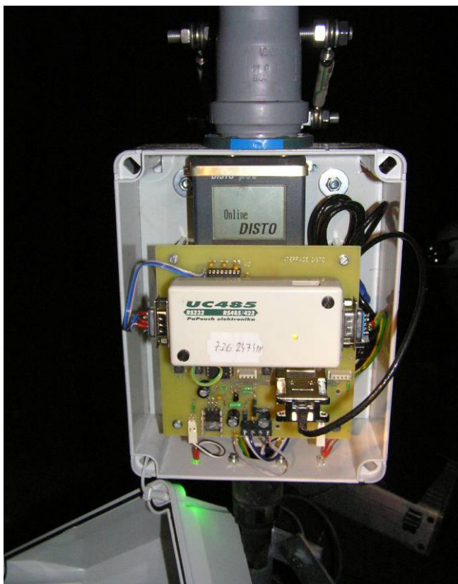
Příloha 3 Instrumentace laserového dálkoměru v komoře K2
