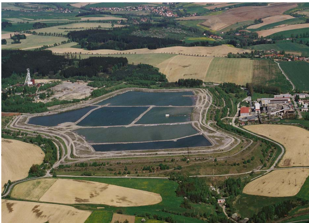
Odkaliště K I (vlevo šachta R 3, vpravo Chem. úpravna)
