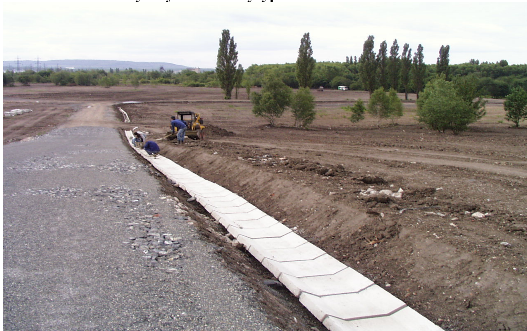
Foto č. 1 - Realizace inženýrských sítí na výsypce
