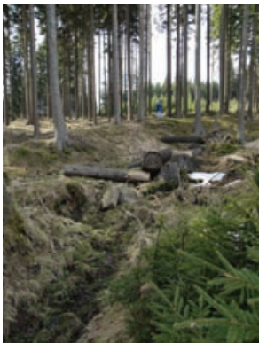
Obr.7 Zabořený portál štolý Prokop
