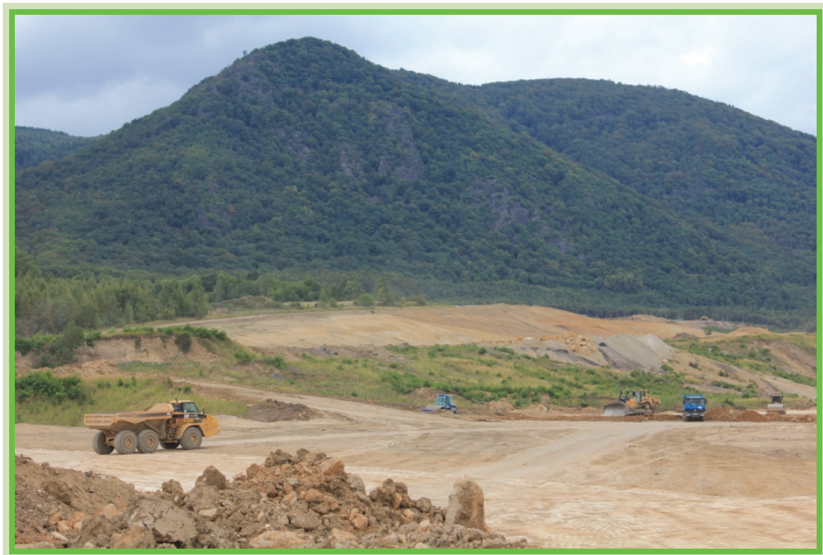
Obrázek č.4 Plocha sanace a rekultivace severozápadních svahů lomu ČSA
