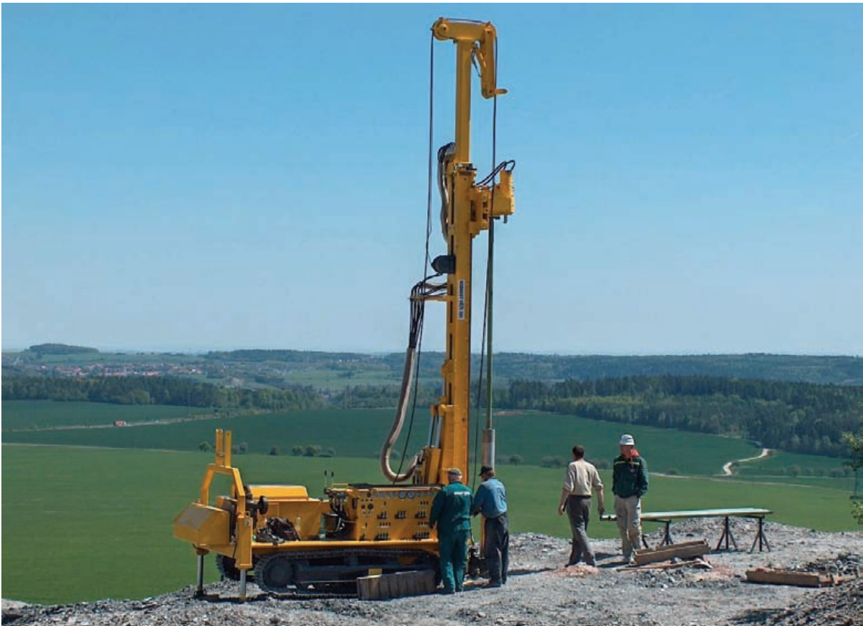
Vrtný průzkum tělesa odvalu
