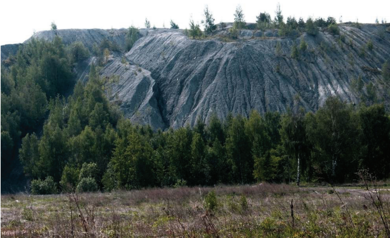
Nestabilní svahy s projevy eroze
