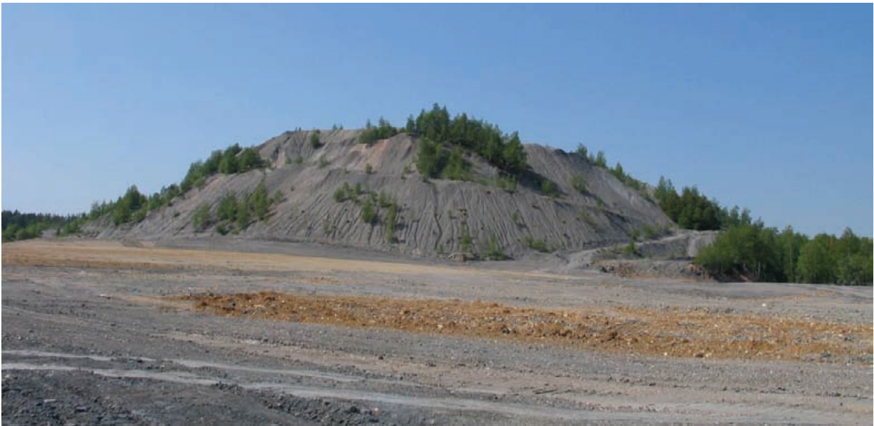
Odval Tuchlovice před zahájením rekultivačních prací
