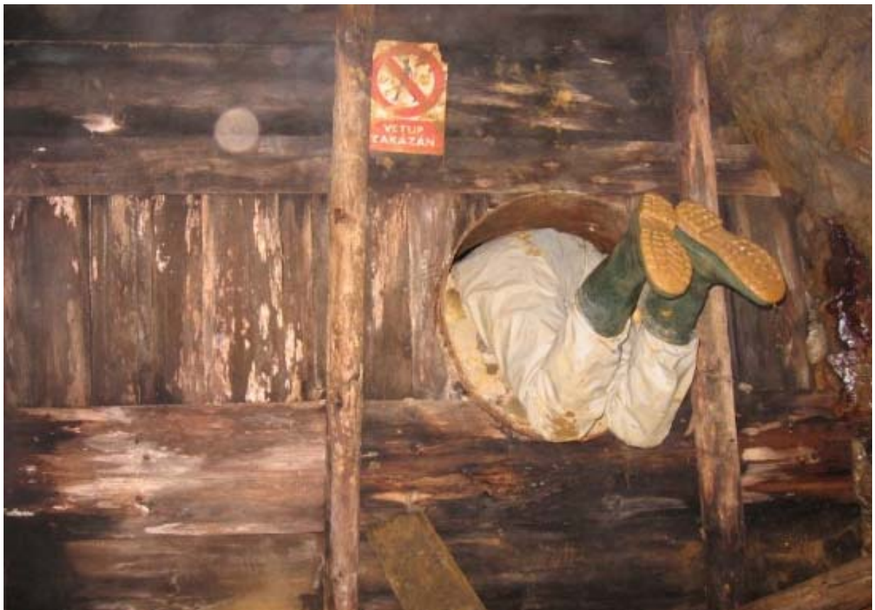
Obr. 2 Průchod hrázových objektem
