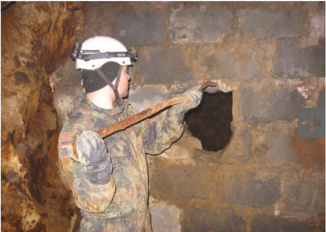
Obr. 1 Zprůchodnění a poškození objektu hráze
