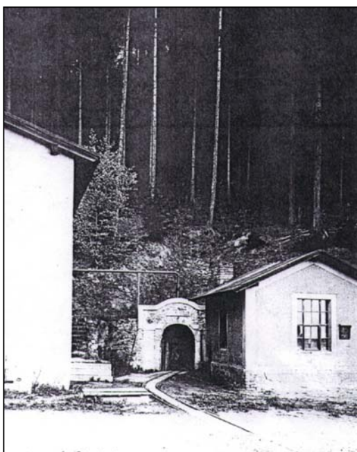
obr.č.6 portál štoly rok 1942
