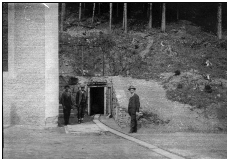
obr.č.4 portál z roku 1916
