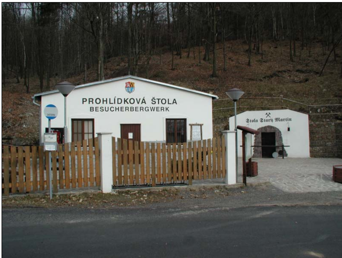
obr.č.12 stávající portál štoly
